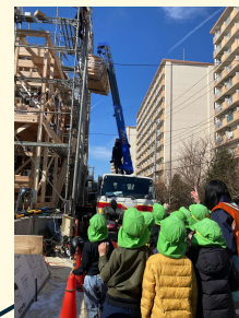
建築現場を見学する様子
